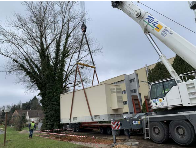
L'installation d'un nœud de raccordement à Sarlat a sonné le début du déploiement de la fibre optique en sarladais.
